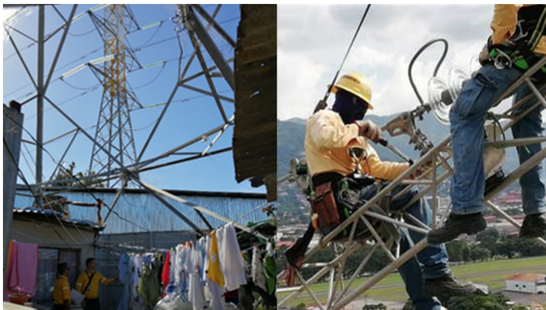
Trabajo de desmantelamiento de la línea de transmisión eléctrica.
