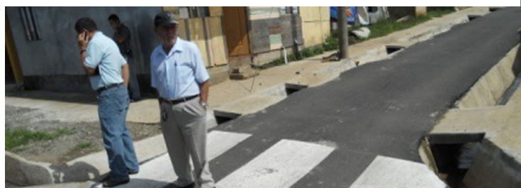
Llanos De Santa Lucía después. Carretera en asfalto con señalización, cordón de caño, aceras y rampas de acceso posterior a la inversión en Llanos de Santa Lucía. Fuente MIVAH DIGITE 2012.
