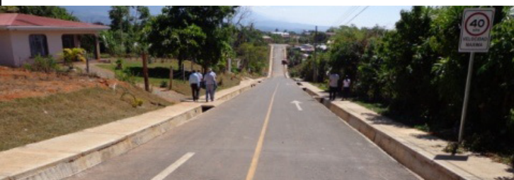
Lomas De Cocorí después. Carretera con cordón y caño, asfaltada y señalizada posterior a la intervención con el bono comunal en Lomas de Cocorí. Fuente MIVAH DIGITE 2013.
