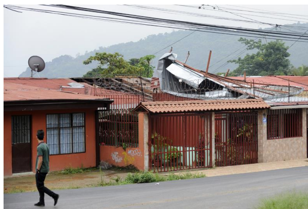
Figura 7.6. Desprendimiento de clavadoras, elementos de la estructura y cubierta de techo
