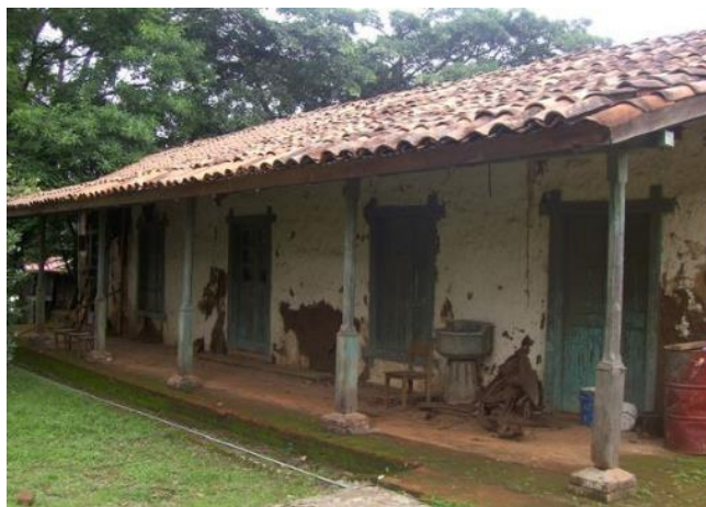
Figura 6.23. Muros y paredes de adobe o bahareque
