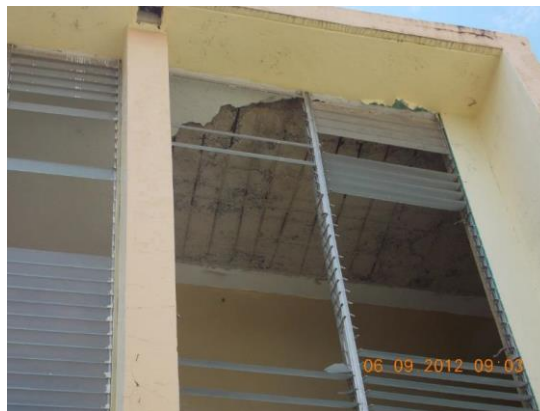
Figura 8.9. Caída del repello de un entrepiso
