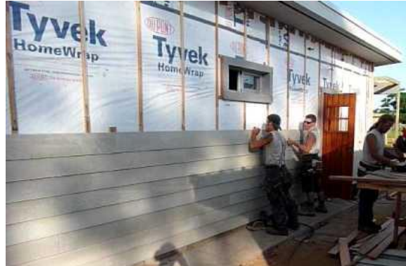
Figura 6.16. Forro con lámina de fibrocemento
