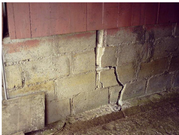
Figura 7.3. Grieta evidente tanto en pared como cimiento
