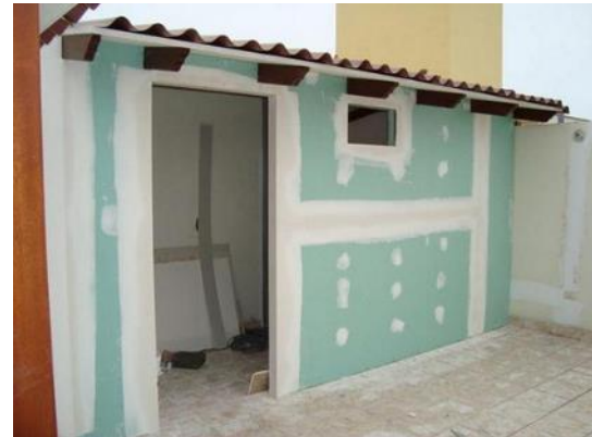
Figura 6.18. Forro con lámina de yeso
