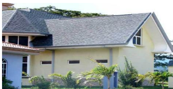
Figura 6.41. Teja asfáltica
