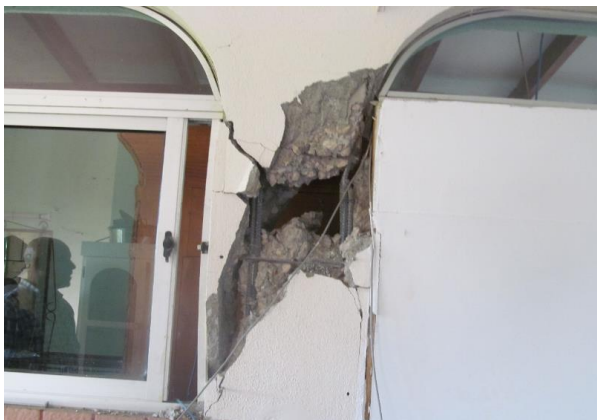
Figura 7.9. Grietas en diagonal grave en columna, desprendimiento del concreto y acero de refuerzo expuesto
