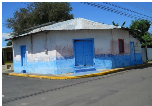
Figura 6.24. Muros y paredes de adobe o bahareque
