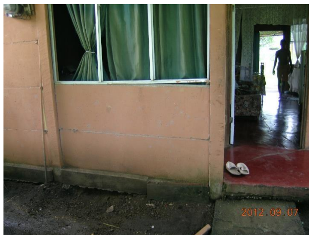
Figura 7.4. Grieta evidente en el cimiento de la baldosa horizontal
