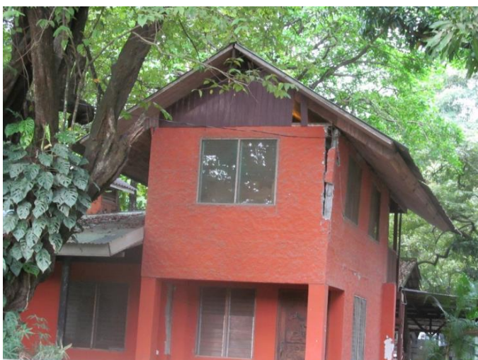
Figura 7.14. Grieta vertical en la intersección de paredes
