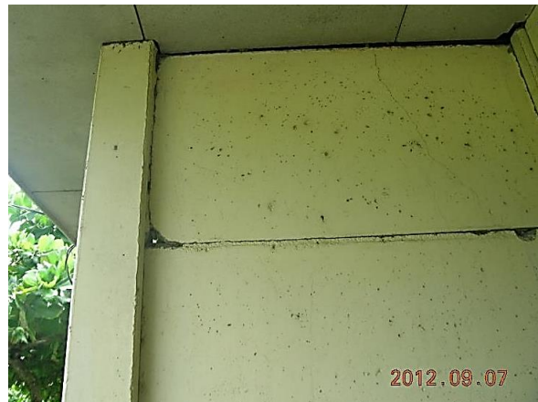
Figura 7.17. Separación entre columna y baldosa y entre baldosa y baldosa
