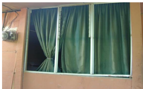
Figura 8.2. Marco de ventanas deformado por movimiento de las baldosas
