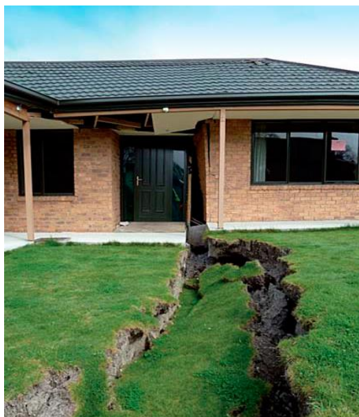
Figura 9.6. Grieta causada por la licuación del terreno
