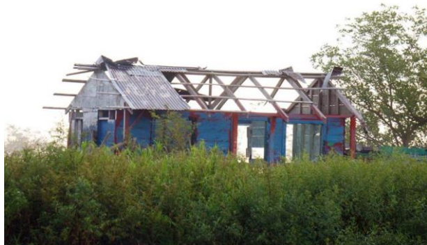
Figura 8.4. Desprendimiento de la cubierta de techo
