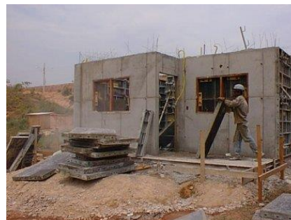
Figura 6.6. Muros y paredes de concreto reforzado
