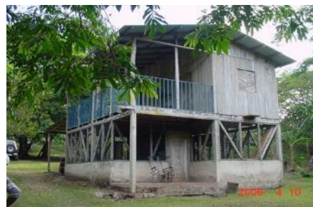
Figura 6.20. Estructura de madera con forro de tabloncillo en el segundo piso sobre un muro de bloques de concreto.
