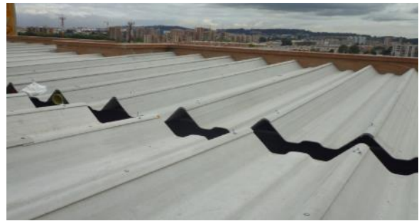
Figura 6.43. Canaleta estructural de fibrocemento o asbesto cemento. Por la edad de la vivienda se puede determinar si es fibrocemento o asbesto cemento.
