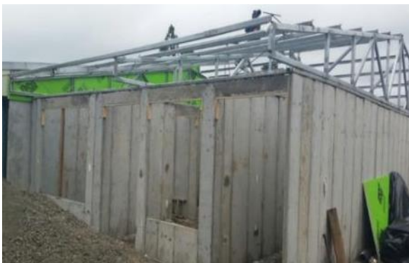
Figura 6.34. Cerchas construidas con elementos de acero
