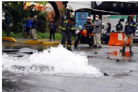
Figura 9.17. Fuga en tubería agua potable
