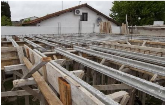
Figura 6.52. Viguetas de concreto presforzado
