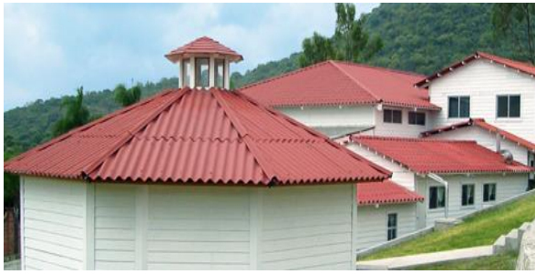
Figura 6.42. Lámina ondulada de fibrocemento o asbesto cemento la cual ya no se fabrica, pero se conoce de su existencia en viviendas de Zetillal, Mozotal, La Facio, Hatillos, Pavas y Tibás.
