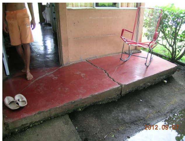
Figura 8.11. Grietas en contrapiso por asentamiento del terreno
