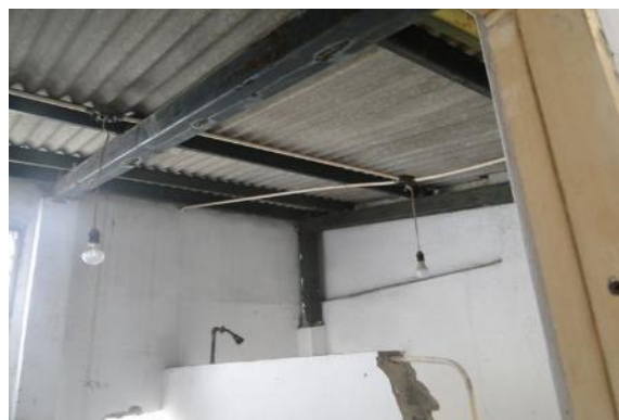
Figura 6.37. Vigas de acero bien acabadas o cubiertas por un cielo falso
