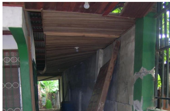
Figura 8.7. Caída parcial de cielo falso
