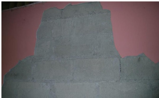
Figura 8.8. Caída del repello de una pared
