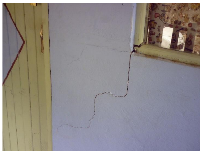
Figura 7.13. Grieta diagonal en pared de mampostería
