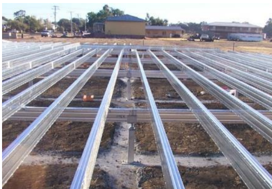
Figura 6.54. Viguetas de acero. Estas pueden ser de perfiles RT individuales o compuestos, elementos de sección rectangular hueca, elementos de sección I o armaduras.
