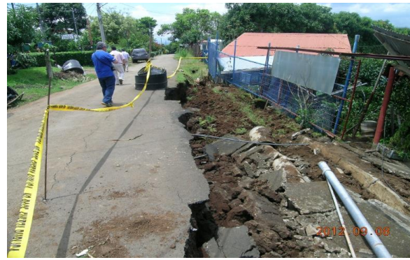
Figura 9.10. Asentamiento del terreno por deslizamiento de un talud
