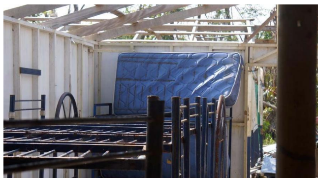
Figura 8.5. Desprendimiento de la cubierta de techo
