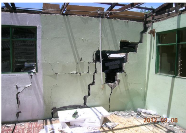
Figura 7.12. Grieta diagonal en pared de mampostería con desprendimiento de bloques
