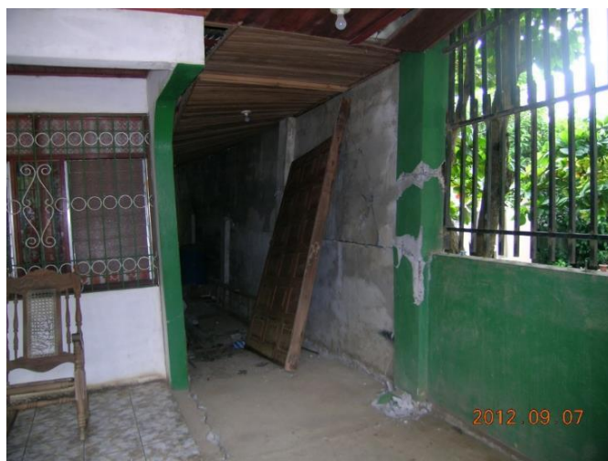
Figura 7.15. Grieta horizontal en pared de mampostería
