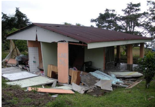
Figura 7.24. Desprendimiento de paneles verticales
