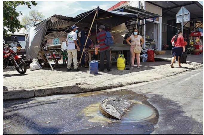
Figura 9.15. Fuga en alcantarillado aguas residuales
