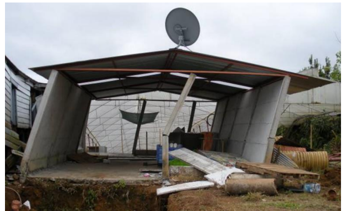
Figura 7.19. Inclinación grave de paredes de baldosas horizontales.
