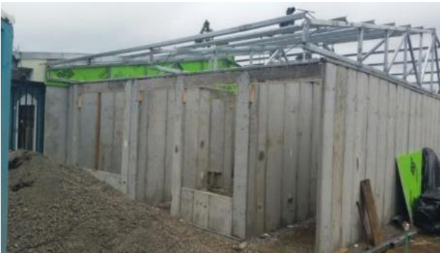
Figura 6.9. Prefabricado vertical con paneles angostos.
