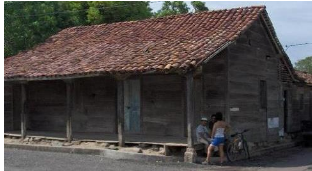
Figura 6.12. Estructura de madera forrada con tablones de madera
