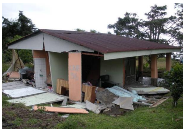
Figura 7.2. Ejemplo de colapso a pesar de que ciertos elementos estructurales de la vivienda siguen en pie
