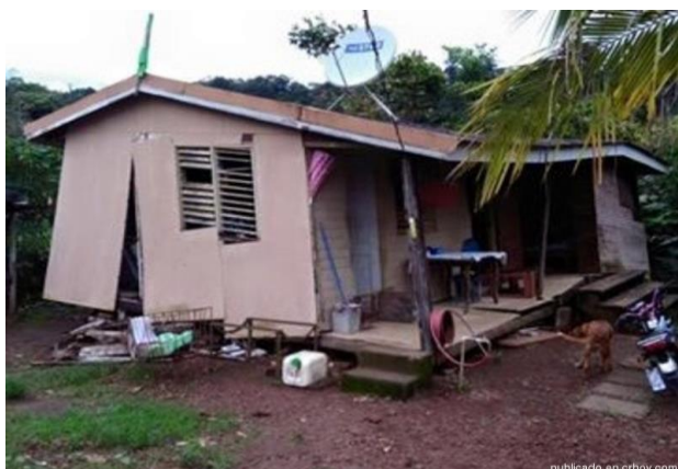
Figura 7.30. Vivienda con desprendimiento de láminas de fibrocemento por desgarre o aplastamiento de láminas alrededor de los elementos de fijación o por desprendimiento de dichos elementos.
