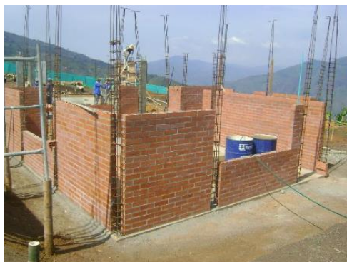
Figura 6.3 Mampostería confinada con bloques de arcilla
