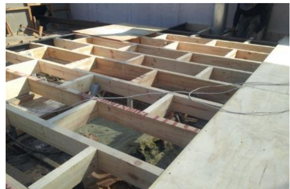
Figura 6.55. Viguetas de madera. Estas pueden ser de piezas rectangulares sólidas o laminadas.
