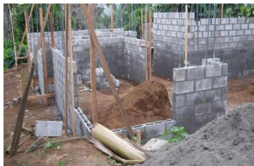
Figura 6.2. Mampostería integral con bloques de concreto
