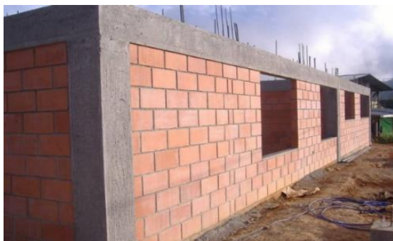
Figura 6.1 Mampostería integral con bloques de arcilla
