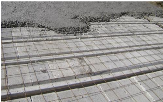
Figura 6.47. Una sobrelosa consiste de una losa de concreto de 50 o 75 mm de espesor colada sobre viguetas de concreto.
