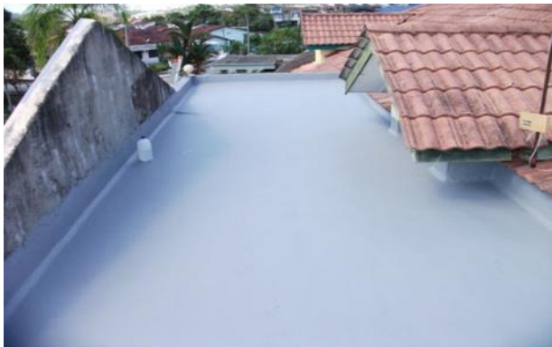
Figura 6.44. Losa de techo de concreto reforzado impermeabilizada
