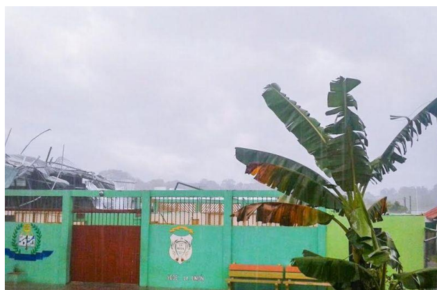
Figura 7.5. Desprendimiento total de la estructura de techo
