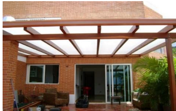
Figura 6.45. Lámina de policarbonato. También se pueden utilizar láminas acrílicas onduladas.
