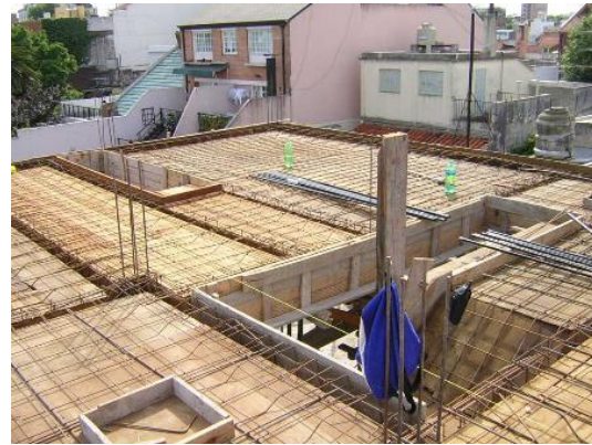
Figura 6.57. Losa monolítica de concreto la cual cumple una doble función: como tablero y vigueta.
