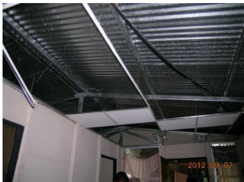
Figura 8.6. Caída de láminas de cielo falso y estructura de soporte
