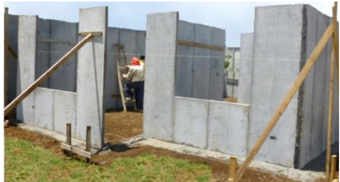
Figura 6.10. Prefabricado vertical con paneles anchos.
