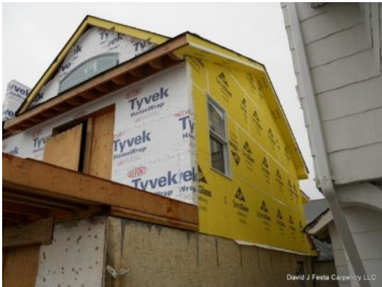
Figura 6.17. Forro con lámina de fibra de vidrio
