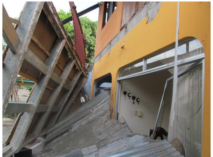
Figura 7.36. Caída de entrepiso por falla en la conexión de las vigas de entrepiso a la pared
