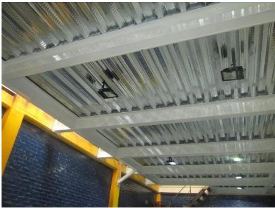
Figura 6.56. Lámina portante de acero que se muestra es una lámina de acero nervada que cumple la función de formaleta y es capaz de soportar el concreto fresco, el acero de refuerzo y las cargas de construcción.
