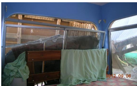
Figura 8.1. Desprendimiento de ventanas
