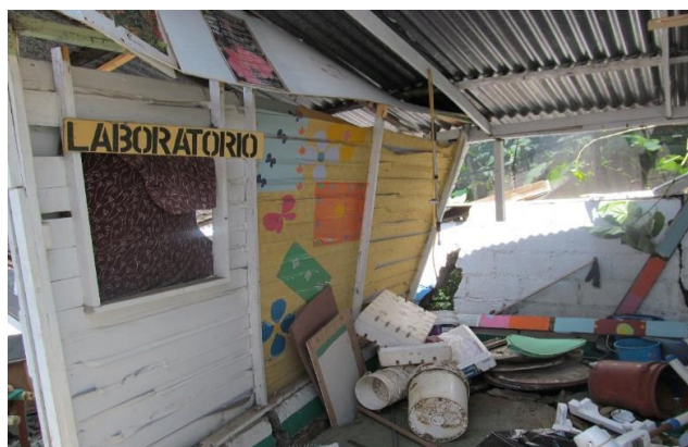
Figura 7.31. Inclinación fuera del plano de pared forrada con tablilla de madera
