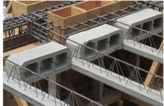
Figura 6.53. Viguetas de concreto con armadura de acero
