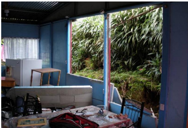
Figura 7.18 Desprendimiento localizado de baldosas por falla en la conexión columna-solera
