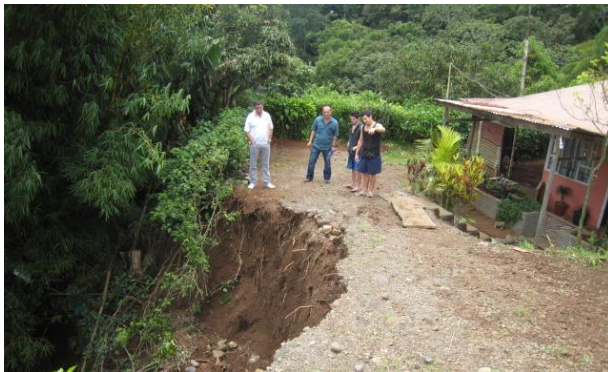
Figura 9.9. Deslizamiento de talud que amenaza la estabilidad de una vivienda
