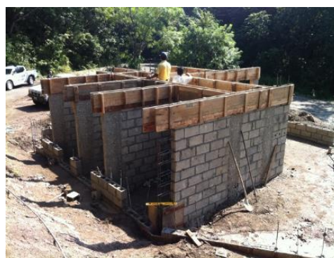
Figura 6.4. Mampostería confinada con bloques de concreto
