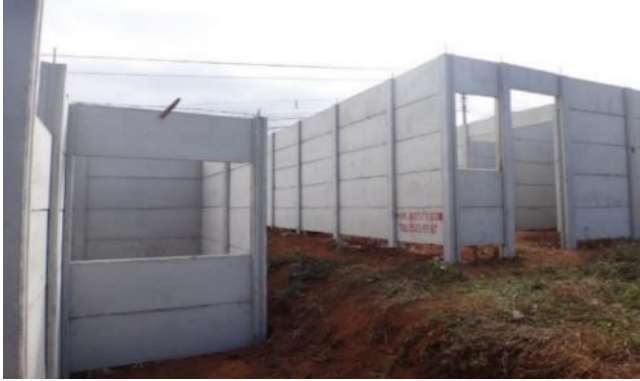
Figura 6.7. Prefabricado horizontal en construcción
