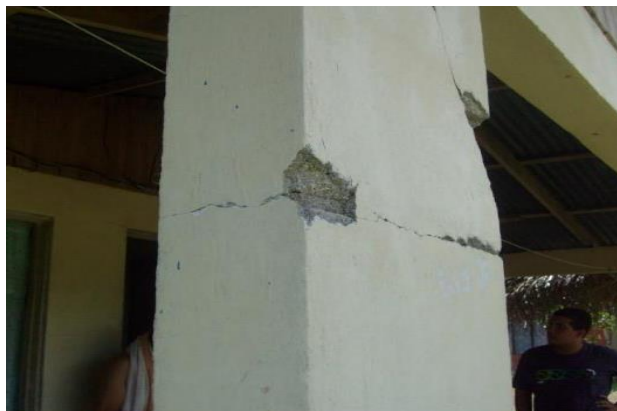
Figura 7.10. Grieta horizontal al medio de la columna con desprendimiento del repello
