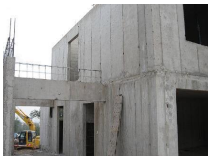
Figura 6.5 Muros y paredes de concreto reforzado
