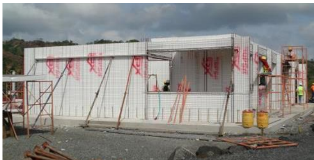
Figura 6.13. Sistema emparedado listo para aplicar el mortero
