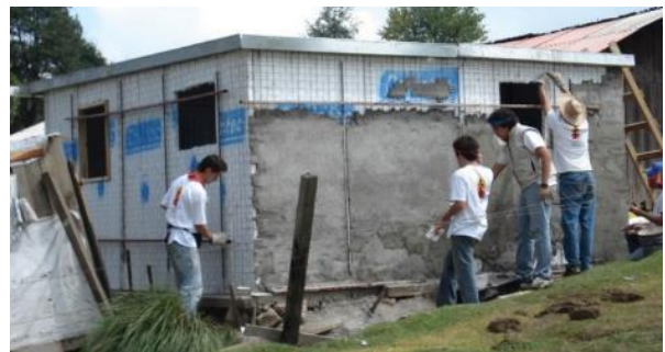
Figura 6.14. sistema emparedado al que se le está aplicando mortero
