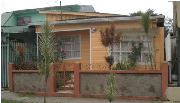
Figura 6.11. Estructura de madera forrada con tabloncillo de madera
