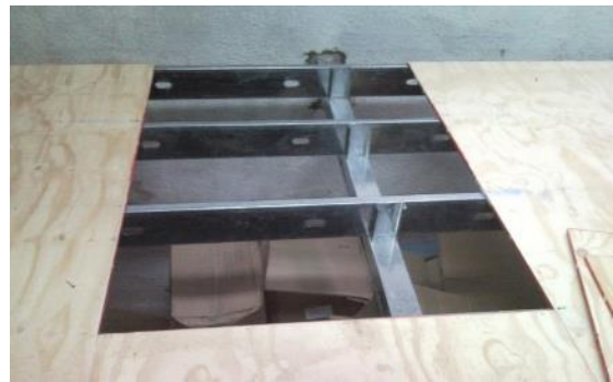
Figura 6.48. Las láminas de plywood para piso pueden tener espesores de 13 y 16 mm dependiendo de la separación de las viguetas de soporte.
