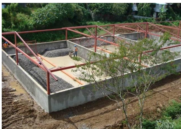
Bono comunal. Planta de tratamiento en construcción. Llanos de Santa Lucía.
