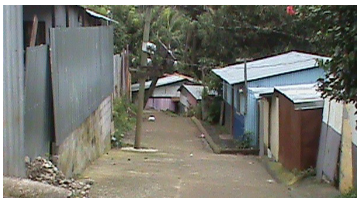
Calles de concreto construidas por la comunidad que no reúnen las condiciones de acceso según la Ley 7600. Fuente: MIVAH DIGITE 2013.
